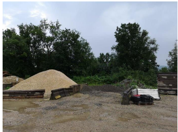
Foto 25: frei geräumtes Baufeld im Plangebiet
