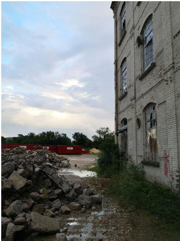
Foto 31: leerstehendes Fabrikgebäude im Plangebiet
