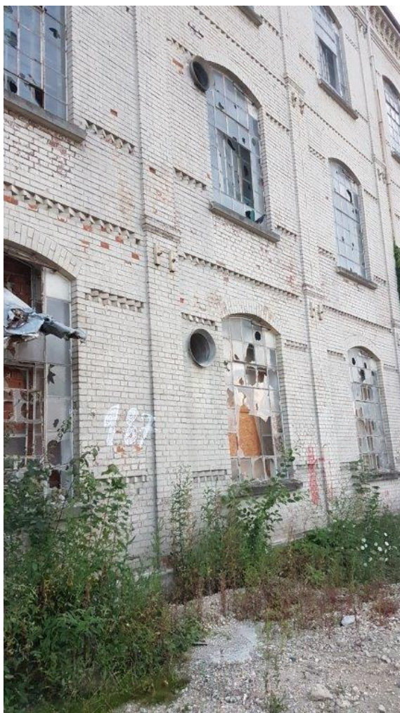
Foto 28: leerstehendes Fabrikgebäude mit Einflugmöglichkeiten
