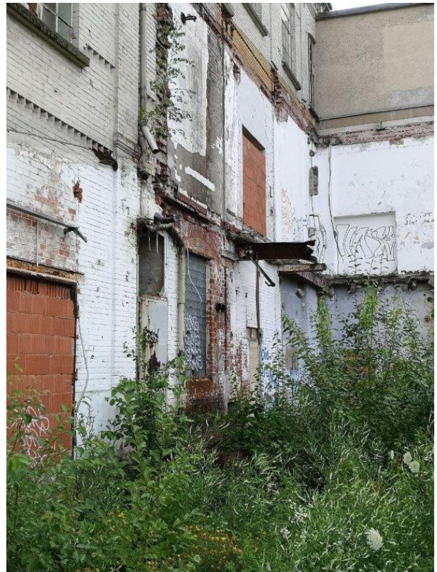
Foto 32: leerstehendes Fabrikgebäude im Plangebiet
