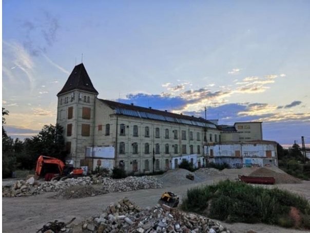
Foto 22: Leerstehendes Fabrikgebäude im Plangebiet
