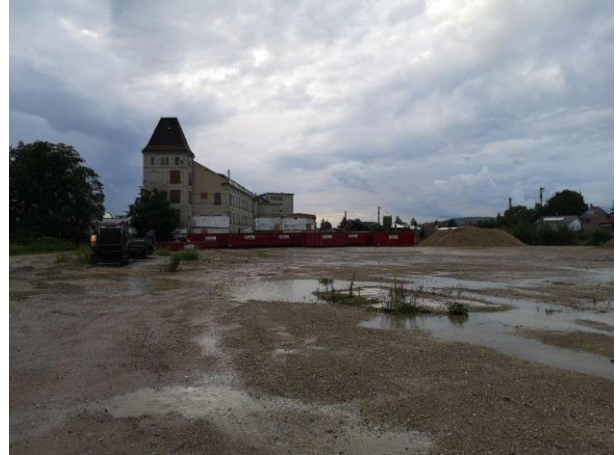
Foto 23: frei geräumtes Baufeld im Plangebiet
