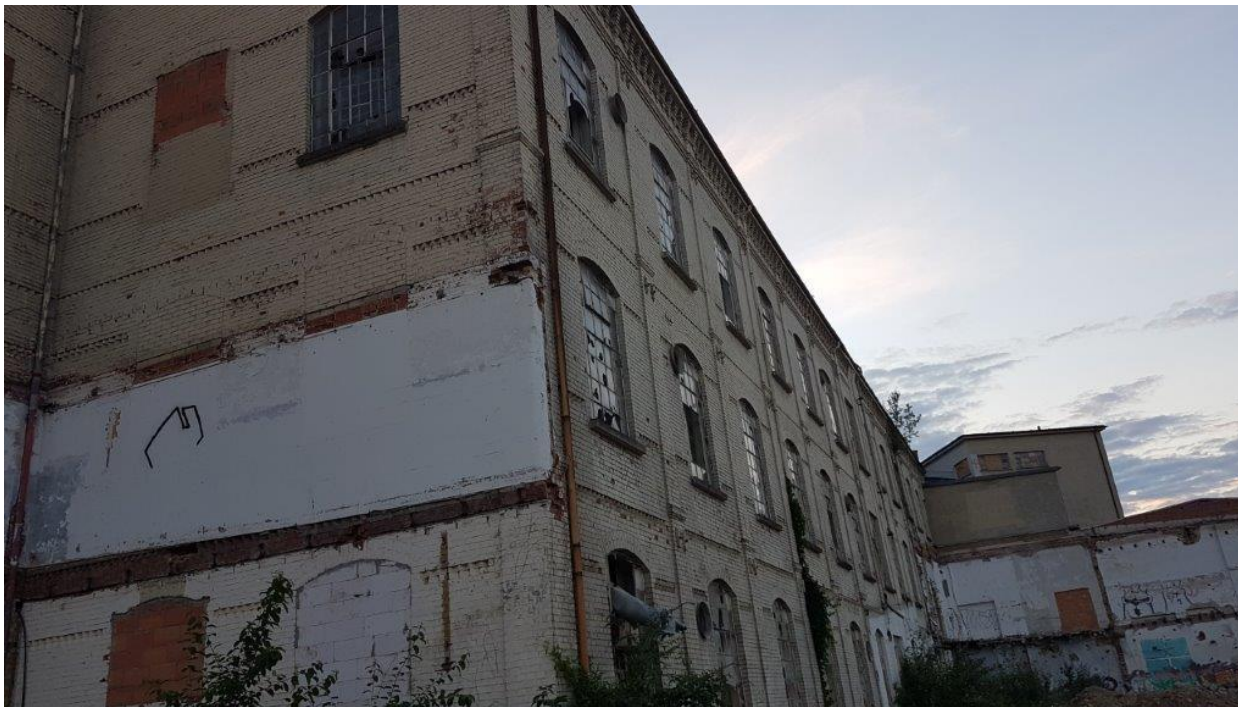
Foto 9 – 10: Einflugmöglichkeiten im alten Fabrikgebäude
