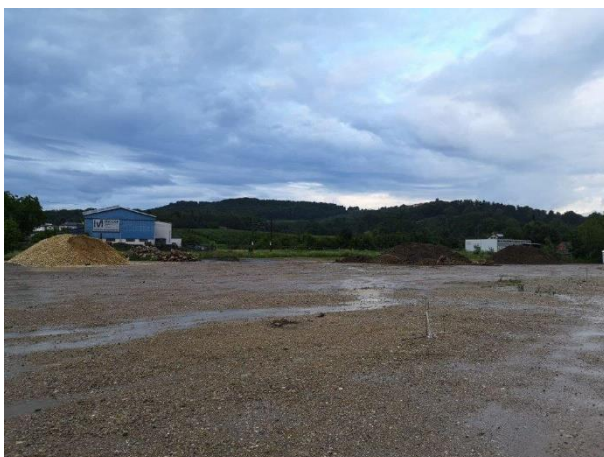
Foto 26: frei geräumtes Baufeld im Plangebiet
