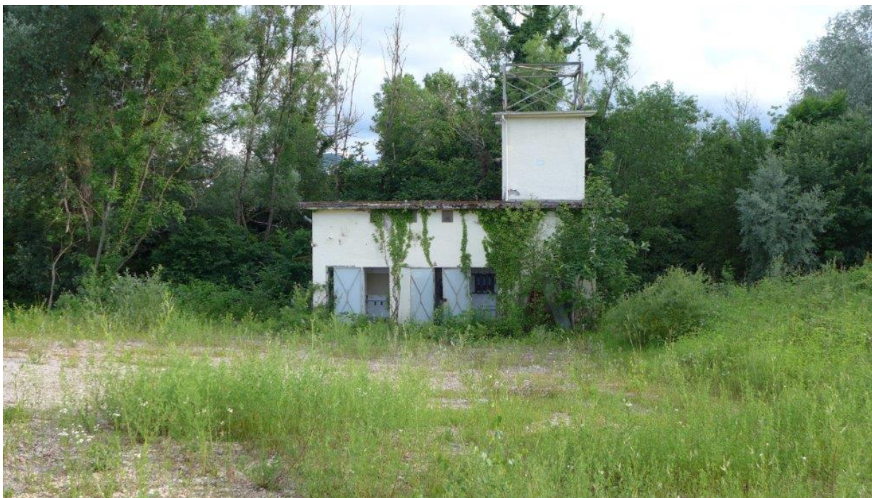
Foto 33: Ufersaum der Fils mit Trafohäuschen
