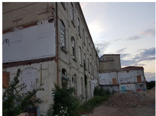
Foto 27: leerstehendes Fabrikgebäude im Plangebiet
