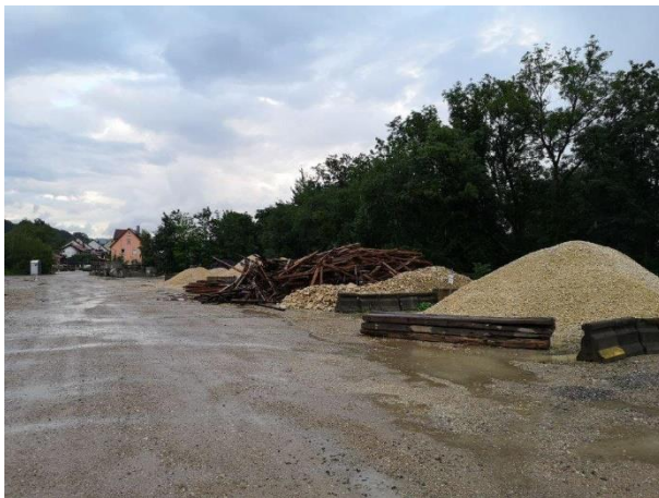
Foto 24: frei geräumtes Baufeld im Plangebiet
