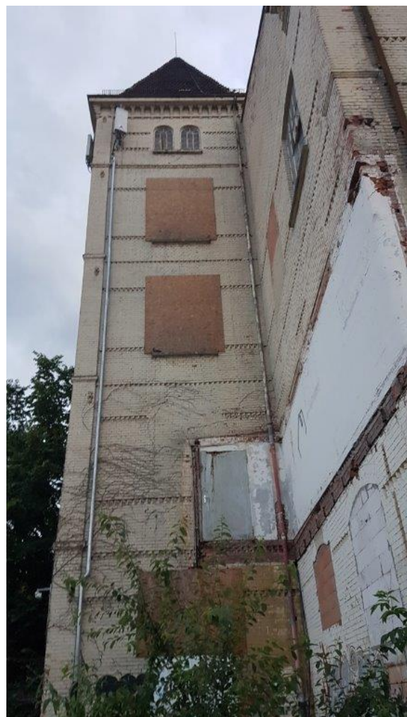
Foto 29: leerstehendes Fabrikgebäude mit Einflugmöglichkeiten
